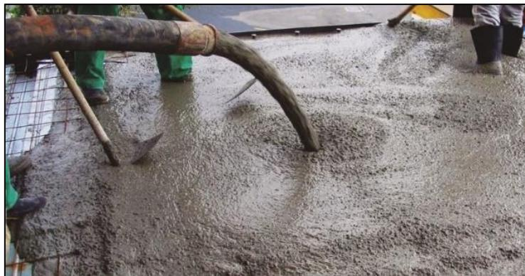
*FIGURA 4. VACIADO DE CONCRETO AUTOCOMPACTABLE EN OBRA.*
