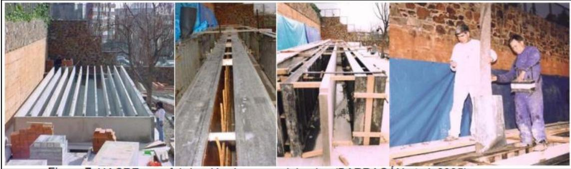
FIGURA 23. MUROS PREFABRICADOS MEDIANTE CONCRETO AUTOCOMPACTABLE.
