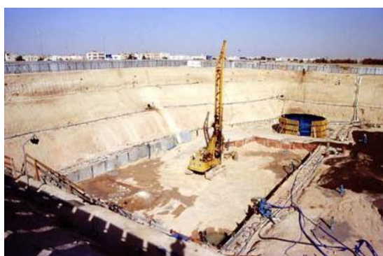
Ilustración 2. 4° nivel de wellpoint insuficiente.
