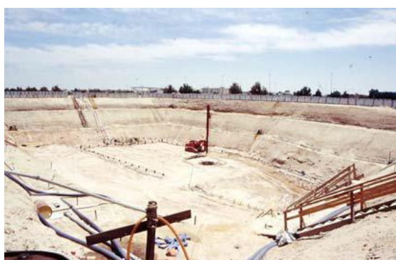
Ilustración 1. 3° nivel de wellpoint.
