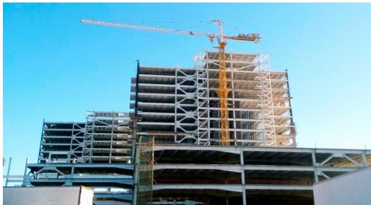
**Figura 6** Centro comercial La Ceiba con sistema estructural a base de contravientos tipo X
