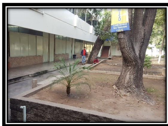
Figura 29.- Ventanas Cubiertas con Lamina de Metal. Fotografía Actual
