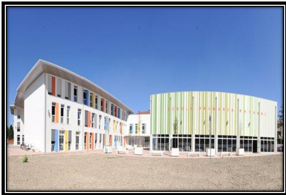
Figura 17.- Nuova Scuola Primaria P. Racagni. Italia. Primer edificio LEED Oro.
