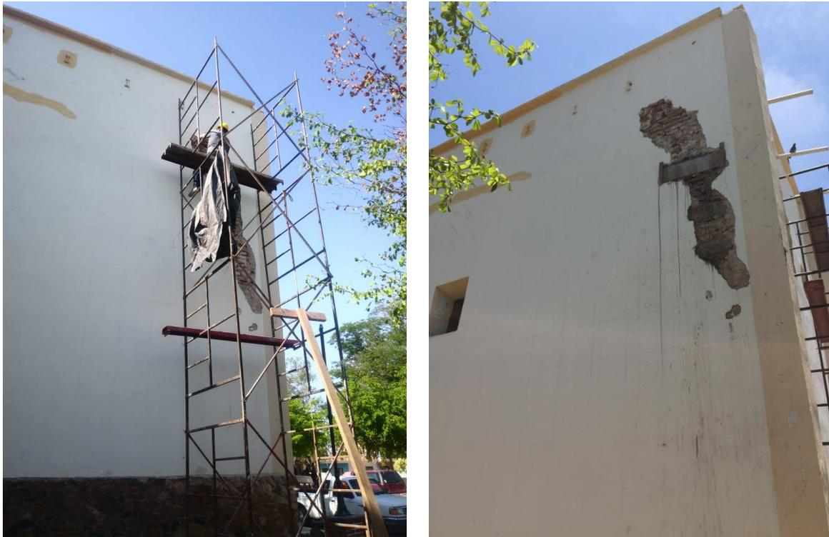
**Figura 32.- Relleno de grietas y sustitución de piezas de tabique dañadas (Muro norte).**
