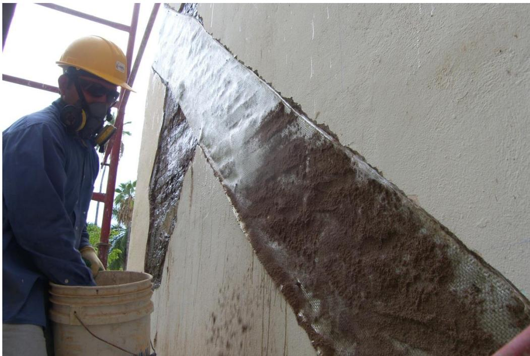
**Figura 38.- Aplicación de areneo sobre refuerzo de fibra de vidrio (muro sur).**
