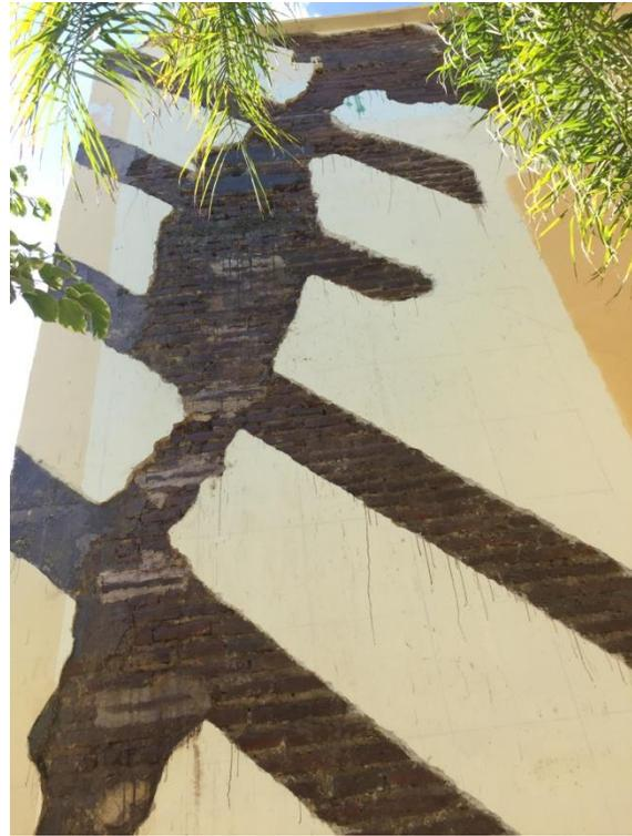
**Figura 33.- Aplicación de capa de impregnación muro norte (izquierda) y muro sur (derecha).**
