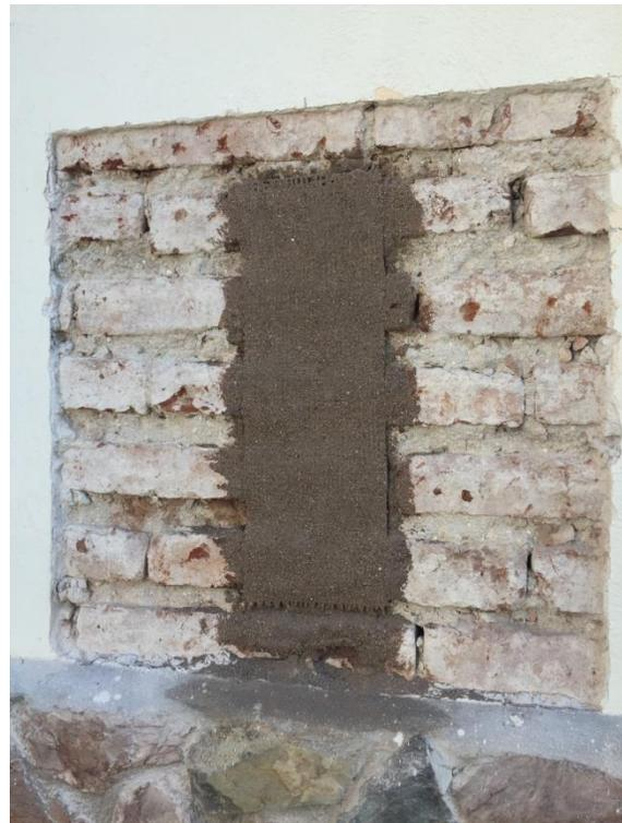
**Figura 28.- Impregnación de fibra (izquierda) y areneo (derecha).**
