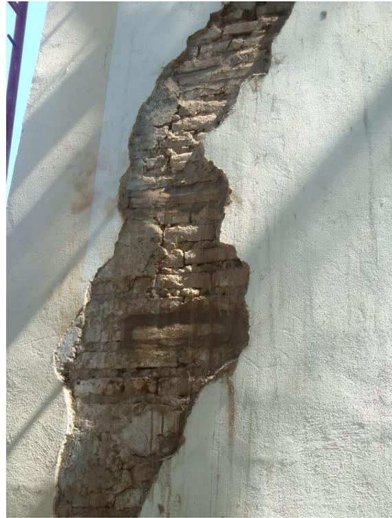
**Figura 30.- Relleno de grietas y sustitución de piezas de tabique dañadas (Muro sur).**
