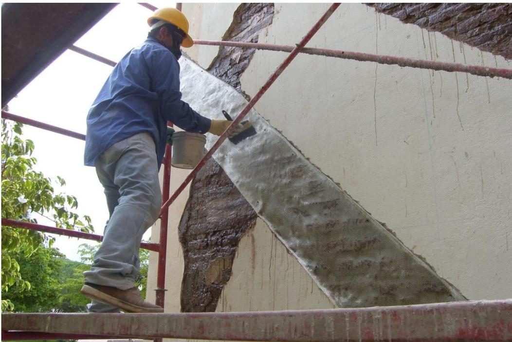
Figura 36.- Aplicación de fibra de vidrio (petatillo) e impregnación con resina poliéster (muro sur).
