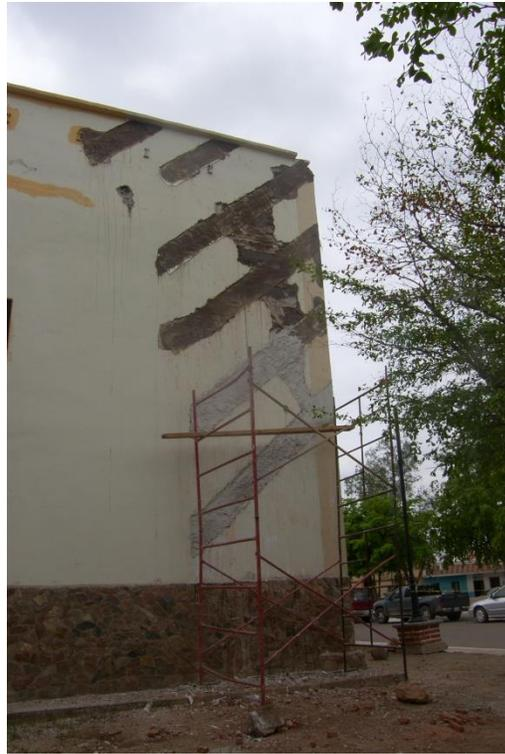
**Figura 39.- Areneo en muro poniente (izquierda) y aplanado cal-arena en muro norte (derecha).**
