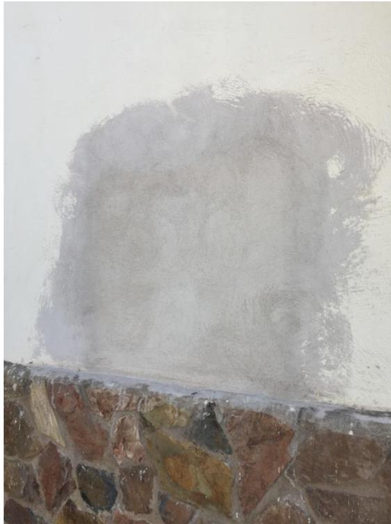
**Figura 29.- Acabado final en muro con aplanado cal-arena.**
