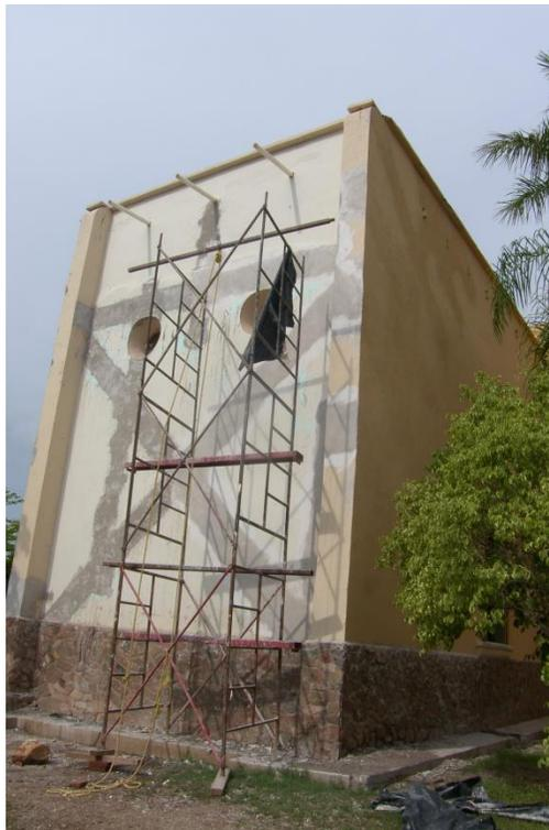
**Figura 40.- Aplanado con mortero cal-arena en muro poniente.**
