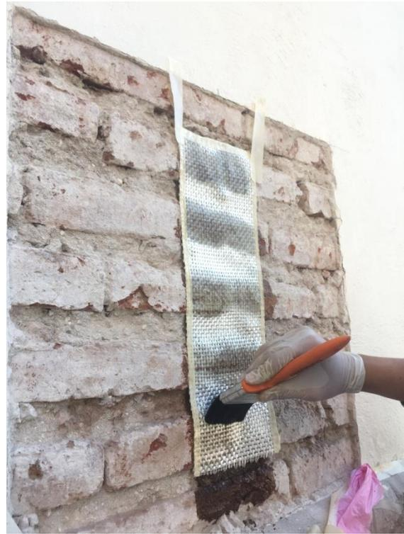
**Figura 27.- Colocación de fibra de vidrio (izquierda) e impregnación de fibra (derecha).**
