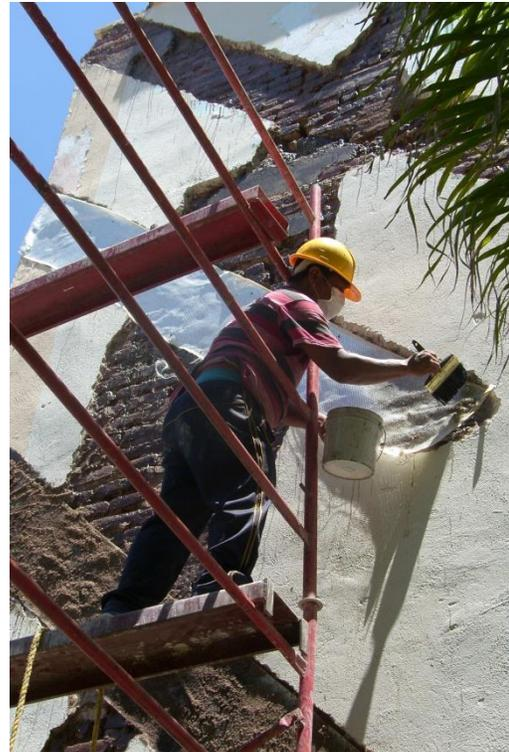
**Figura 37.- Aplicación de fibra de vidrio, muro norte (izquierda) y muro sur (derecha).**
