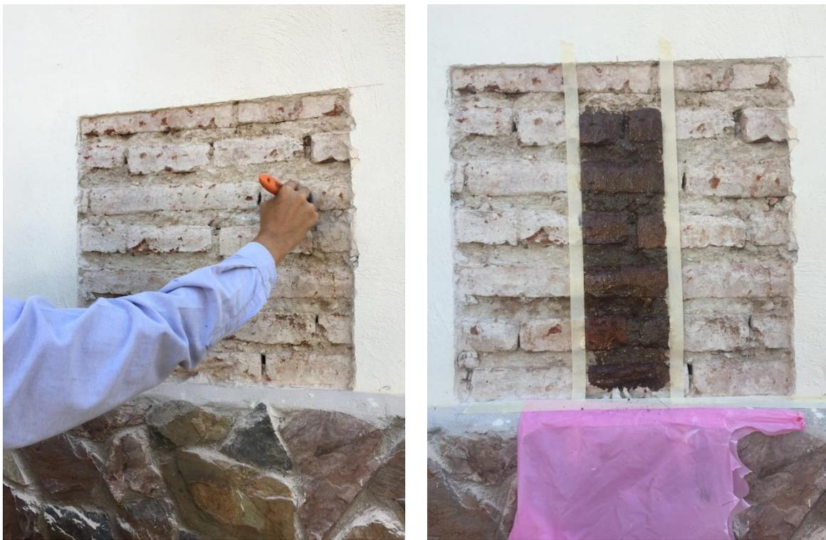
**Figura 26.- Limpieza de superficie (izquierda) e impregnación de resina (derecha).**
