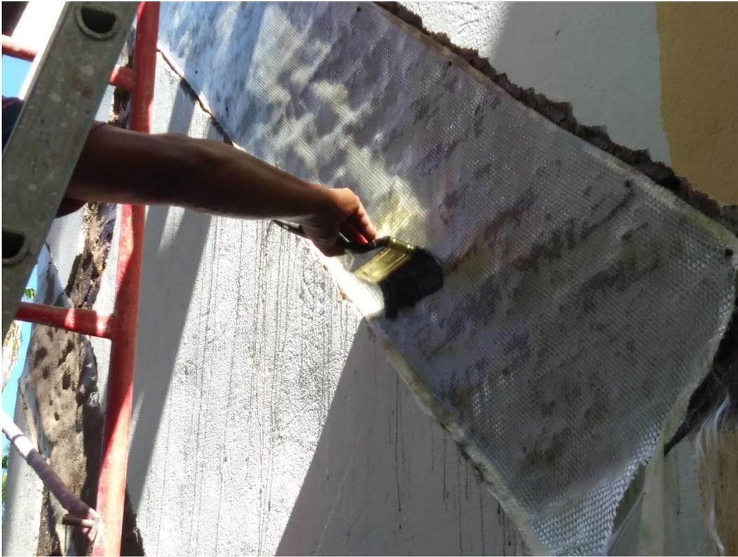
Figura 35.- Aplicación de fibra de vidrio (petatillo) e impregnación con resina poliéster (muro sur).
