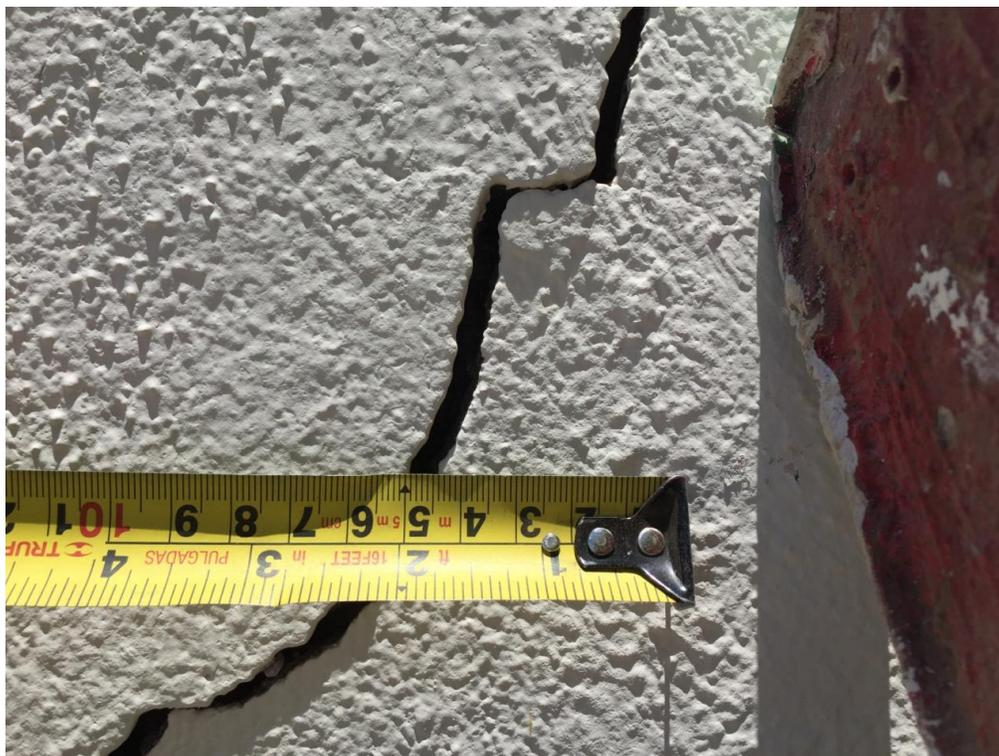
Figura 18.- Espesor de grieta máximo (5mm)
