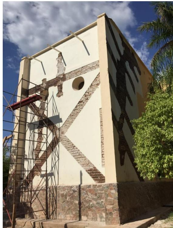
**Figura 34.- Aplicación de capa de impregnación en muro poniente.**
