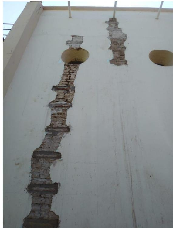
**Figura 31.- Relleno de grietas y sustitución de piezas de tabique (Muro poniente).**
